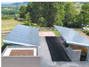
Rénovation de l'ancienne gendarmerie de Tramayes : ombrière de parking.
